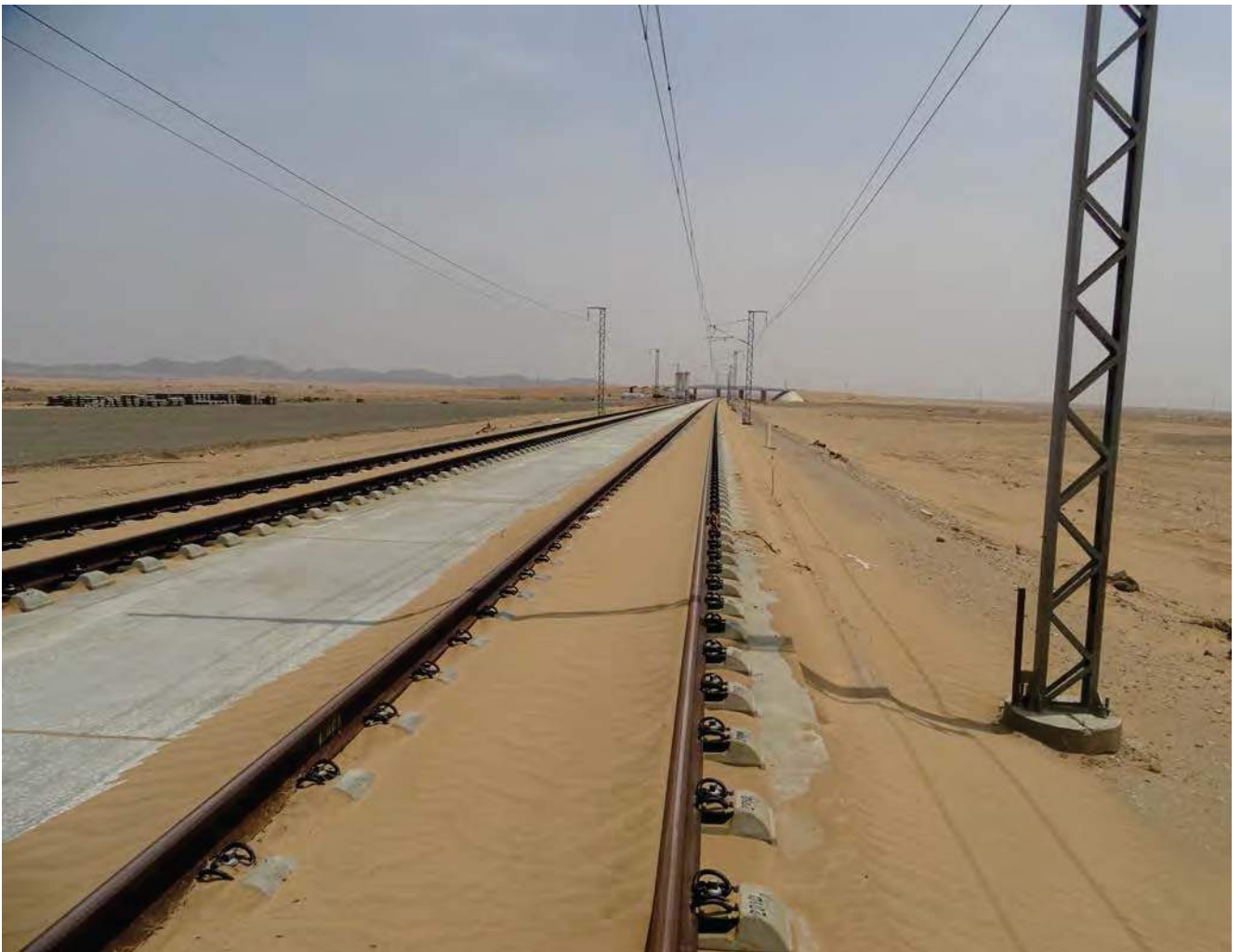
Vías ferroviarias antes de la instalación de Sand Trap
